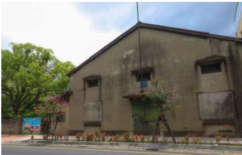
原臺灣省糧食局苗栗倉庫
