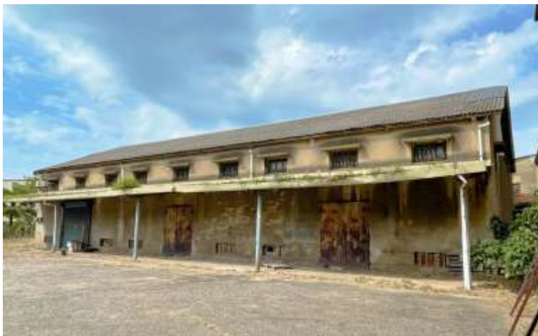
原臺灣省糧食局苗栗倉庫
