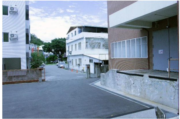
卸貨區出入口
